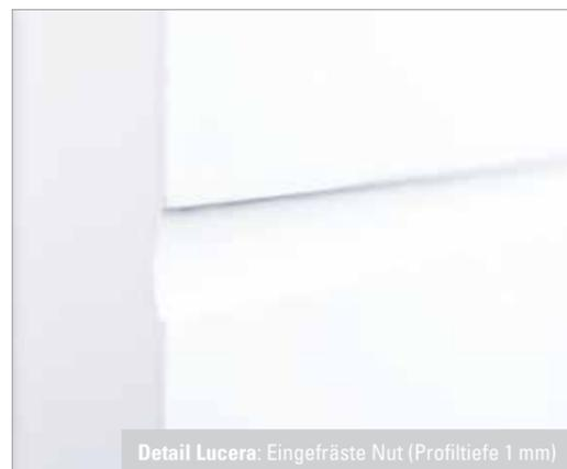
Detail Lucera: Eingefräste Nut (Profiltiefe 1 mm)
